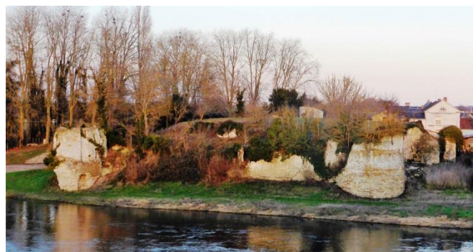
Le château de Nouâtre avec la tour Foulques Nerra (à droite)
