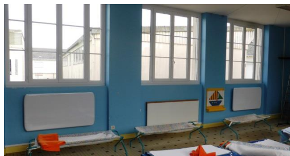
Nouveaux radiateurs posés dans le dortoir de l'école maternelle
